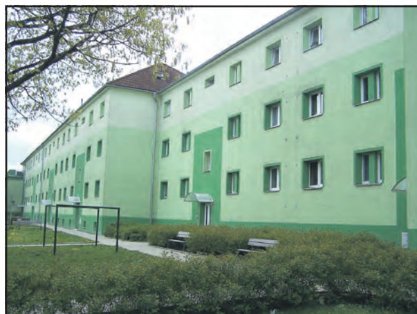
V tomto bytovém domě, který se nachází v ulici 9. května, dojde v brzké době k výměně tzv. ležatého potrubí.
