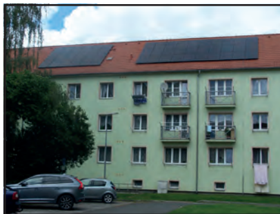
Kdy bude zprovozněna tato fotovoltaika na střeše bytového domu v Hornické ulici?
