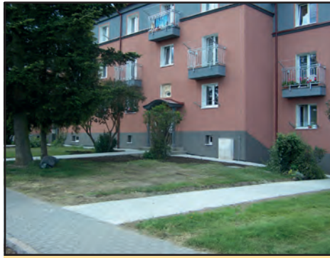
V ulici Švermova byly u nově zrekonstruovaného bytového domu zhotoveny nové přístupové chodníky.
