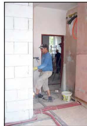
V těchto prostorách, nacházejících se v budově MěÚ Stochov, vzniknou nové ordinace zubních lékařů. V polovině června se zde intenzivně pracovalo.
