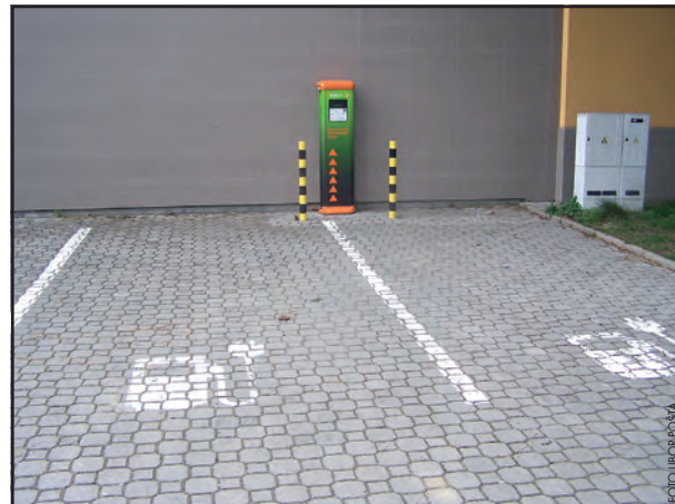
Zatím jediná nabíjecí stanice pro elektromobily se nalézá na východní straně budovy MěÚ Stochov.
