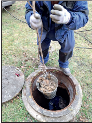
Proplach ucpaného odpadového potrubí. Není to zrovna moc příjemná práce.
