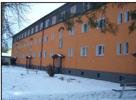
V tomto domě, v ulici Pionýrů, v minulém měsíci probíhaly výměny tzv. ležatých rozvodů.
