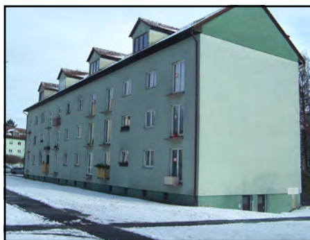
Renovace tohoto domu bude určitým vzorem, či návodem, jak postupovat v renovacích dalších domů v Abecedě.
