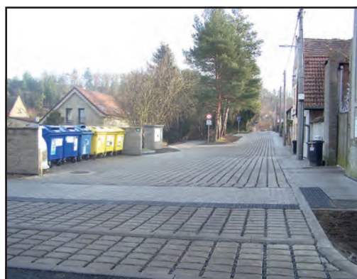
Nově zrekonstruovaná Nová ulice v Čelechovicích.
