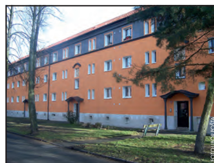
Dům čp. 223-226 v ulici Pionýrů je pěkně zrekonstruovaný, ale ještě v něm bude nutné vyměnit všechny stoupačky.
