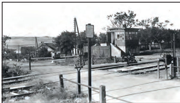
Pohled na železniční přejezd ve 30. letech minulého století. Vpravo od přejezdu je stavědlo St 1, z kterého se obsluhovaly přilehlé výhybky i závory.
