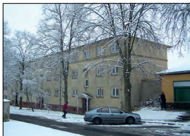
Tento bytový dům v Hornické ulici bude zateplen a vyměněny v něm veškeré stoupačky.
