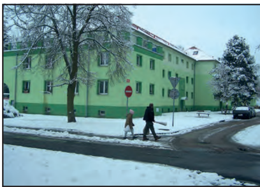
I v tomto domě ve Zborovské ulici budou letos instalovány nové rozvody studené a teplé vody, a také odpadního potrubí.
