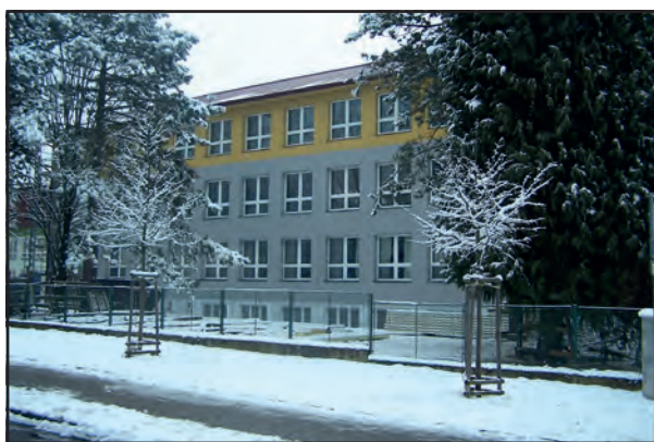
Školní pavilon má již novou fasádu.
