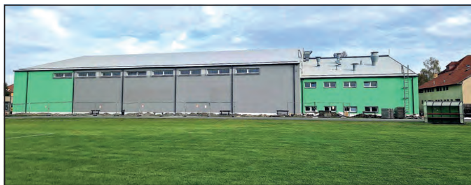
Hala po rekonstrukci.
