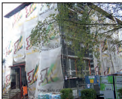
Rekonstrukce školního pavilonu ve stochovském školním areálu probíhá dle představy vedení města.
