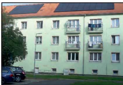
Podobné fotovoltaické elektrárny na dalších střechách bytových domů ve Stochově určitou dobu neuvidíme.
