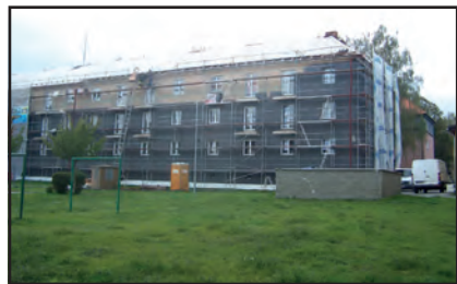
Zateplení domu v ulici Pionýrů by mělo být dokončeno ještě v tomto roce.
