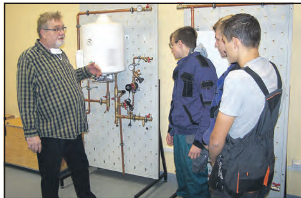
MAS Svatováclavsko, z.s. již podpořila i řadu školských projektů. V tomto případě jde o novou instalatérskou dílnu ve Střední škole služeb a řemesel Stochov.
