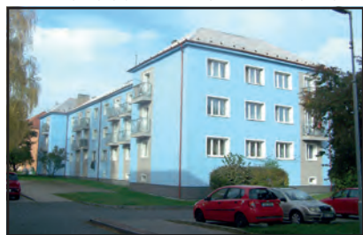
Na tomto domě proběhla oprava plechové střechy a zanedlouho z ní zmizí i dva již zbytečné komíny.
