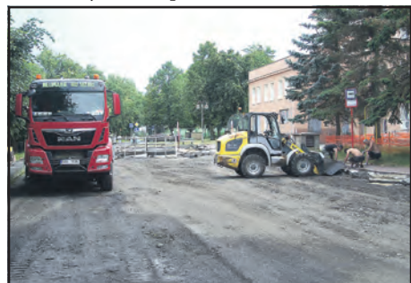
Stavební práce na poslední etapě rekonstrukce ulice 9. května byly již zahájeny.
