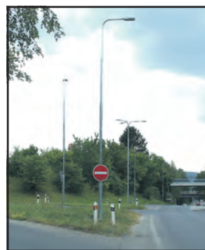
Na poměrně dlouhém úseku silnice ze Slovanky až k OD Tesco byly instalovány nové stožáry uličního osvětlení.
