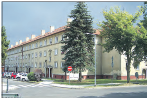
Zateplení tohoto bytového domu v Hornické ulici se posouvá o několik měsíců.
