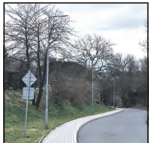
Nové veřejné osvětlení.
