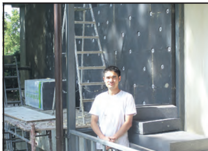
Honza právě zatepluje budovu bývalé putiky.
