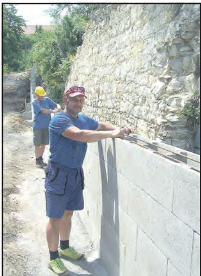
Nová opěrná zeď v areálu TS Stochov se již staví.
